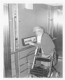
Beispiel einer gelungenen Liftsanierung in einem Blinden- und Sehbehindertenheim in Zürich: Zusätzliches Behindertentableau, doppelte Stockwerkerkennung (oben im Bild der Lautsprecher), erhabene Taster mit eingravierten Normalbuchstaben und Braille-Schrift, gut gekennzeichnetes Nottelefon.
