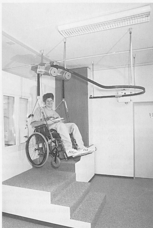
Auch ein Deckenlift für Rollstühle ist in der Musterwohnung integriert.
