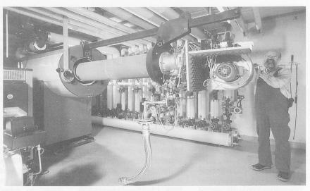
Das keramikfaserbeschichtete Brennrohr des Gebläsebrenners in Lenzburg gibt die Wärme über Infrarotstrahler an den Feuerraum ab. Das gestattet sensationell tiefe Schadstoffwerte (10 mg/m³ NO<sub>X</sub>). Um das Rohr nicht zu beschädigen, wird der Brenner an einer Schiene aus dem Kessel herausgezogen.
