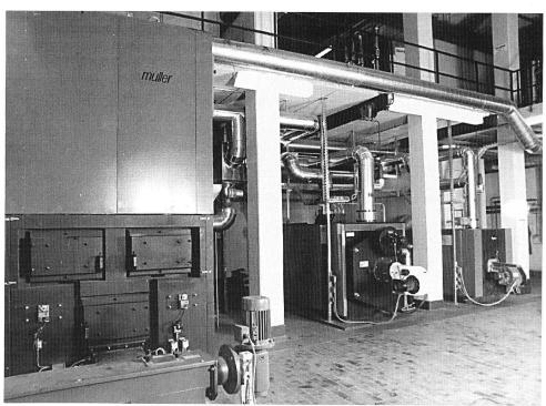
Der Heizraum nach der Sanierung: Links im Bild die neue Holzschnitzelfeuerung mit Low-Nox-Technik, eine Pionieranlage. Foto Johannes Bader
