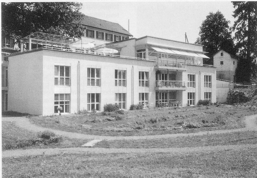
Wichtig für Verwirrte: Klare Ablesbarkeit der Gebäudestruktur.
