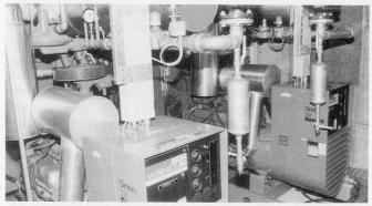
Das Blockheizkraftwerk wandelt das Biogas, welches beim anaeroben Vergärungsprozess entsteht, in elektrische Energie und Wärme um. (Bild: INFOENERGIE, Tänikon).
