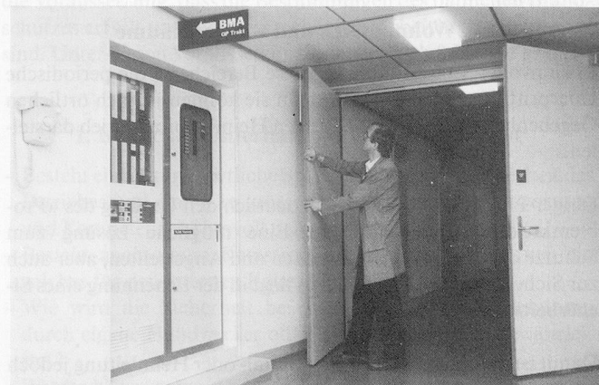
Periodische Kontrolle der Brandschutzeinrichtungen wie Liftanlagen und selbstschliessende Türen (Brandabschlüsse).
