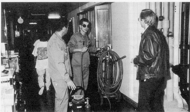
Abprache mit den Handwerkern (vor allem vor Schweissarbeiten) sowie Kontrolle der Abschottung bei Mauerdurchbrüchen.
