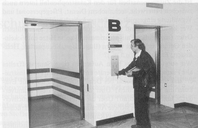
Periodische Kontrolle der Brandschutzeinrichtungen wie Liftanlagen und selbstschliessende Türen (Brandabschlüsse).
