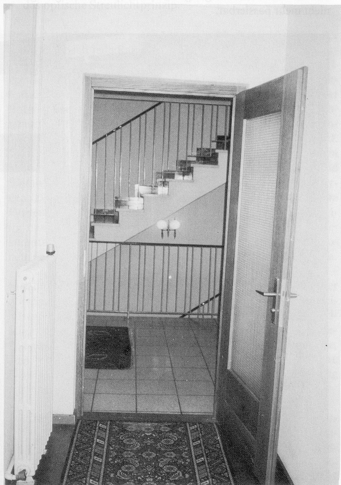
Lange Gänge ohne Brandabschnitt-Unterteilung sowie Türen, welche nicht automatisch schliessen, ermöglichen eine ungehinderte Rauch- und Brandausbreitung.
