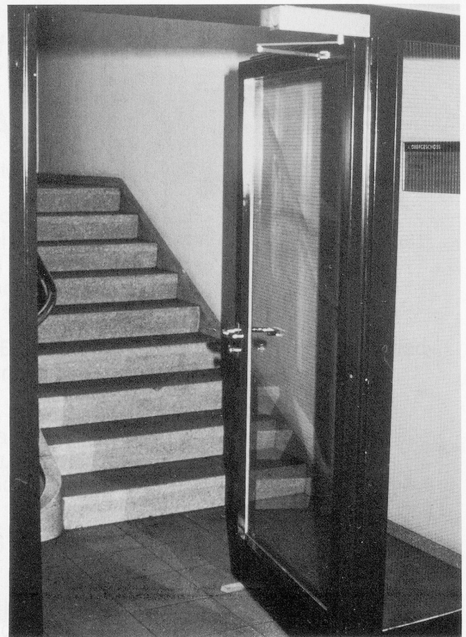
Keile verhindern die selbständige Schliessung von Brandabschnitt-Türen.
