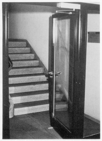
Keile verhindern die selbständige Schliessung von Brandabschnitt-Türen.
