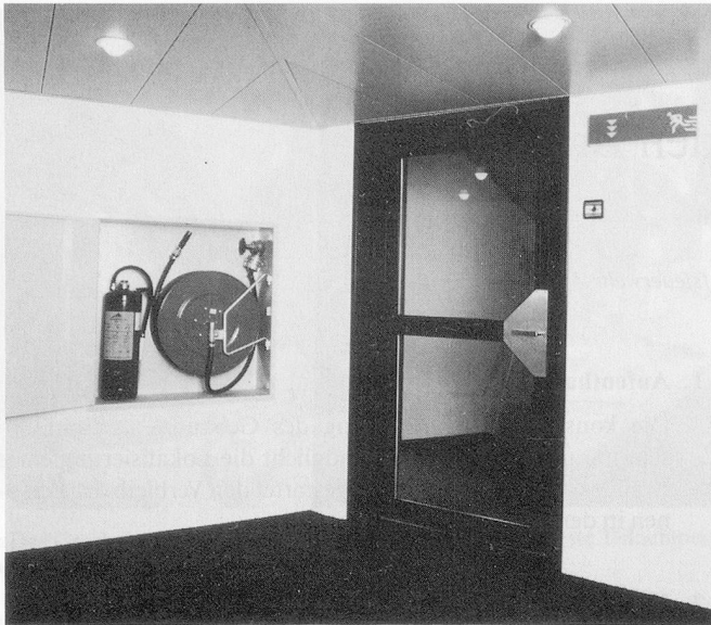
Automatisch schliessende Brandschutztüre mit Fluchtwegbezeichnung, Handalarmtaste und Wandlöschposten.
