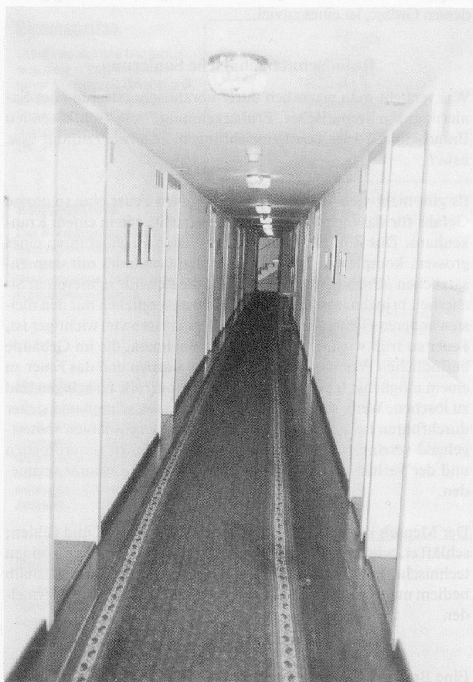
Lange Gänge ohne Brandabschnitt-Unterteilung sowie Türen, welche nicht automatisch schliessen, ermöglichen eine ungehinderte Rauch- und Brandausbreitung.
