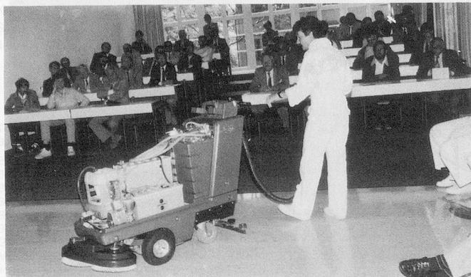
Im Training Center Münchwilen zeigen Profis ihre Techniken, Tricks und Kniffe, wie zum Beispiel hier bei einer Demonstration mit einer mikroprozessorgesteuerten Scheuersaugmaschine.
