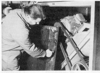
Defekte Monoblock-Isolation belastet die Luftqualität und ist ein idealer Nährboden für Bakterien.
