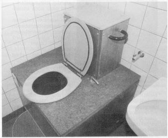
Kompost-WC: am Platz eines normalen WCs steht ein System, welches auf natürliche Weise aus dem Stuhlgang (unter Beizug von Holzspänen) Komposterde «herstellt», und dies ohne Geruchsbelästigung – dank der Lüftung.
