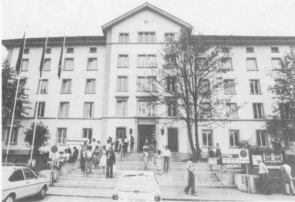
Hinter der Fassade des Dorfzentrums (das vor dem Umbau ein Heim war) verbirgt sich ...
