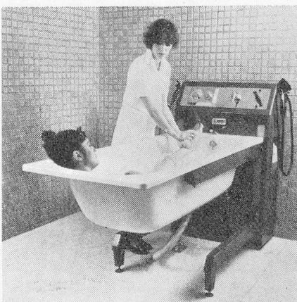
Das LIFTBAD, müheloses und sicheres Baden der Patienten in der jeweils gewünschten Arbeitshöhe. Das LIFTBAD ist in der Höhe stufenlos verstellbar und mit Dusch- sowie Desinfektions- und Reinigungsgeräten versehen.
