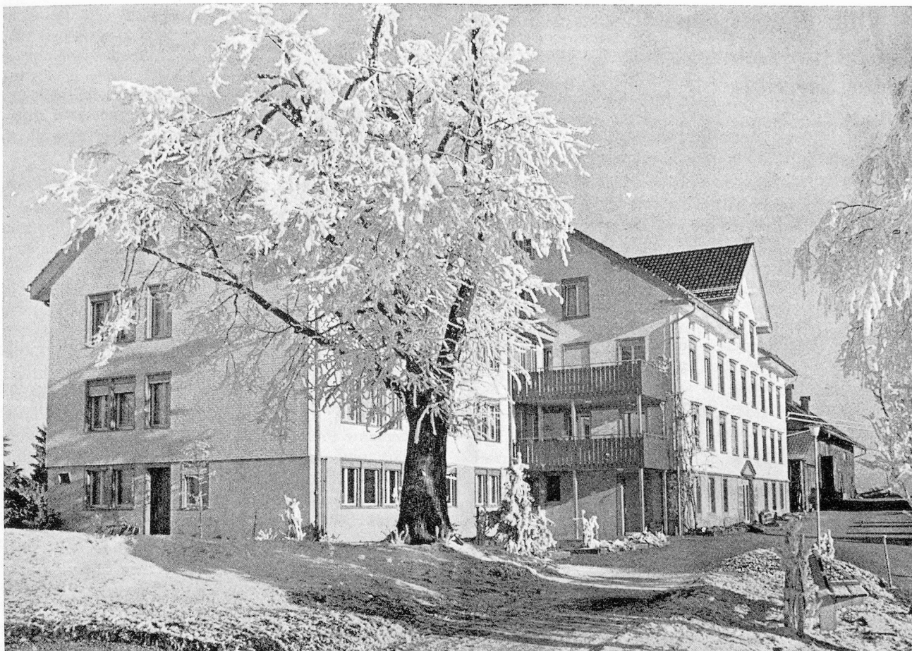
Das Alters- und Bürgerheim Schwellbrunn, erbaut 1901, An- und Umbau 1971/72, präsentiert sich heute als eines der schönsten Heime im Appenzellerland an sonniger Lage, mit Blick ins Säntisgebiet.
