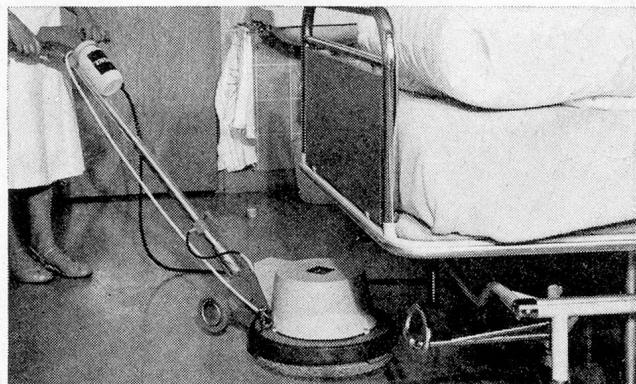
TASKI S – die erste geräuscharme Reinigungsmaschine mit eingebautem Sprayergerät. Niedrige Bauart – leicht verstellbarer Stiel – erleichtert das Arbeiten unter Betten und Tischen.
