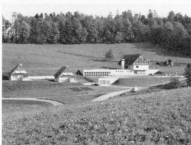
Oberes Bild: Blick auf die verschiedenen Gruppenhäuser; unten — der Clou: das Hallenschwimmbad.
