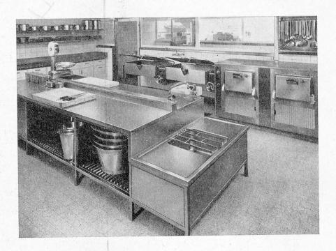
Komplette **Grosskücheneinrichtungen** umfassend: Elektrische Grossküchenapparate sowie Chromnickelstahl-Ausrüstungen, wie Plongen, Arbeitstische, Schubladenstöcke, Geschirr- und Gemüsewaschanlagen inkl. die erforderlichen Küchenmaschinen.
