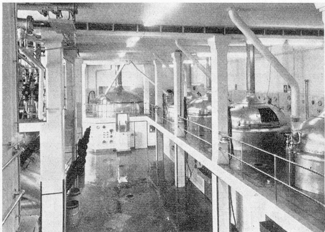
Kupfer-Maischbottiche zur Gewinnung der Malzwürze aus gekeimter Gerste
