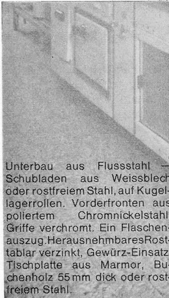
Unterbau aus Flusstahl —
