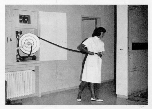
Löschposten (Haushydrant, gleichzeitig mit Feuerlöscher ausgerüstet) mit formbeständigem Hochdruckgummischlauch. Die Speisung des Mehrzweckrohres erfolgt durch die sich drehende Haspelachse—dadurch muss nur die zum Einsatz benötigte Schlauchmenge abgerollt werden.
