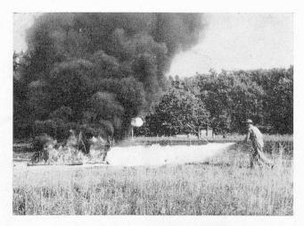
Löschung eines Testfeuers (10 Liter Benzin in einer Wanne von 1 m² Grundfläche) mit einem Staub-Handfeuerlöscher.
