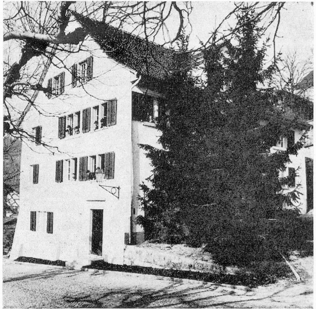
Das umgebaute und renovierte Unterhaus
