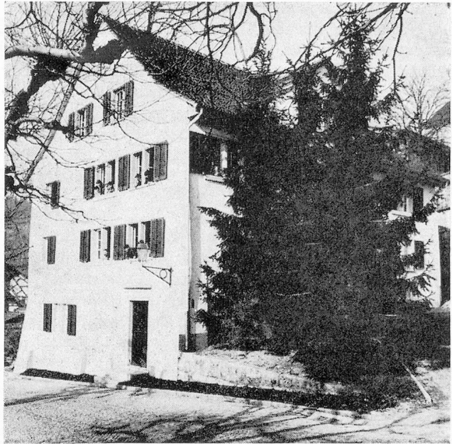
Das umgebaute und renovierte Unterhaus
