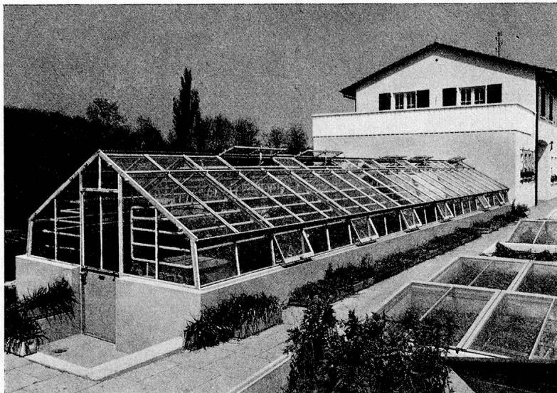
Bacher-Kulturhaus, 3,20 m Innenbreite, abgeteilt in Warm- und Temperaturhaus, mit Dach- und Stehwandluftklappen einzeln bedienbar, Dünrohr-Warmwasserheizung erstellt für Haubensak Söhne AG. im neuen Versuchsgarten Binningen.
