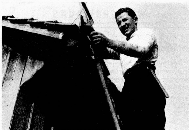
Die Leitung wird vom Haus in ein Nebengebäude im Garten gezogen. Der weisse Isolator ist aus einem Knochen verfertigt
