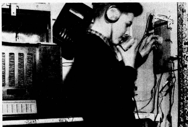
Die Leitung wird vom Haus in ein Nebengebäude im Garten gezogen. Der weisse Isolator ist aus einem Knochen verfertigt
