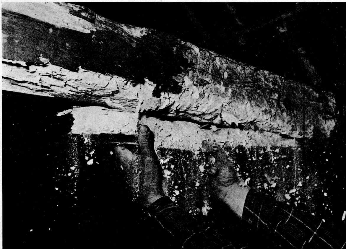
Schaden des Hausbocks in einem Dachstock
