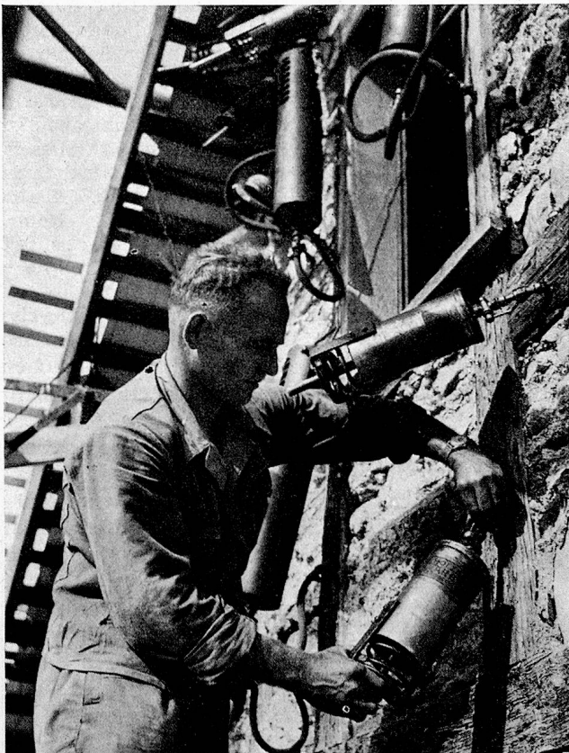
Das eingemauerte Fachwerk bei einem Riegelbau wird mittels spezieller Pressapparate (Arbezol-Presser) mit einem Schutzmittel vollgetränkt.
