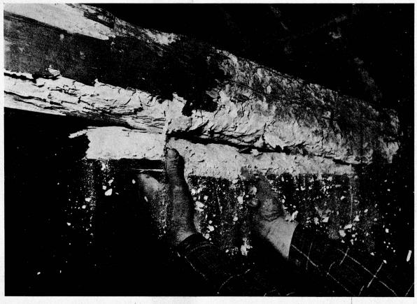
Schaden des Hausbocks in einem Dachstock
