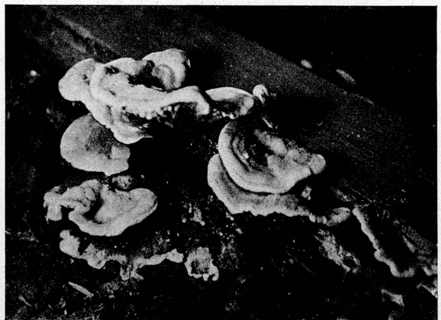
Zerstörung eines Bodenbalkens durch den echten Hausschwamm
