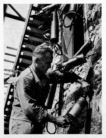
Das eingemauerte Fachwerk bei einem Riegelbau wird mittels spezieller Pressapparate (Arbezol-Presser) mit einem Schutzmittel vollgetränkt.
