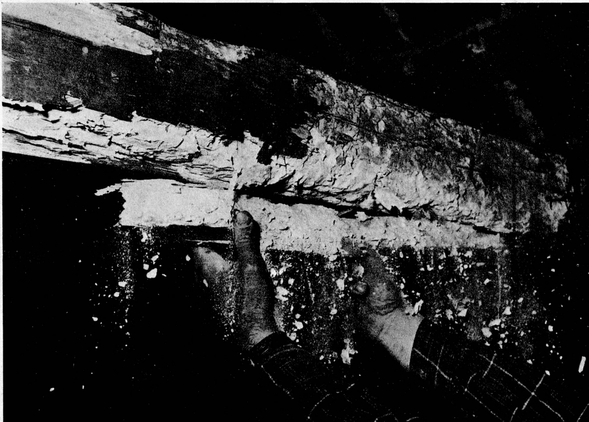
Schaden des Hausbocks in einem Dachstock
