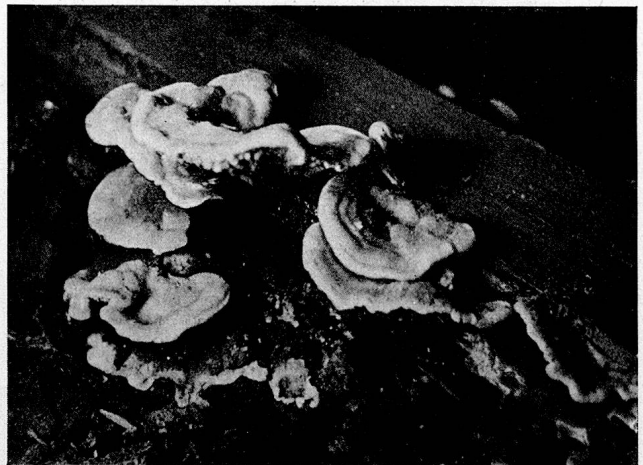
Zerstörung eines Bodenbalkens durch den echten Hausschwamm
