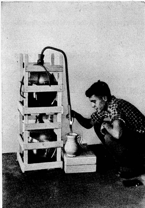
Ausschank mit Siphon (Leistung 12 Liter pro Minute)
