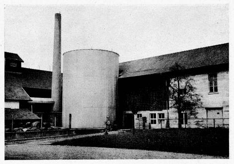
500 000 hl fassender Tank zur Lagerung des süssen Saftes ab der Presse
