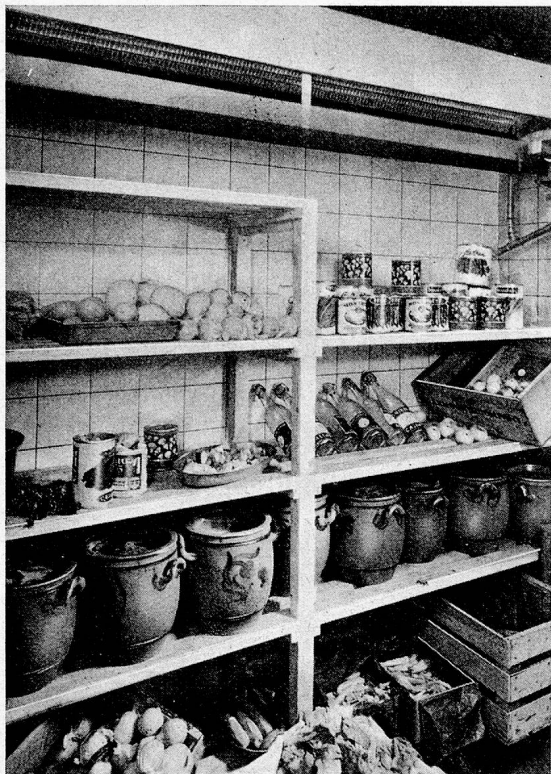
Teilansicht der Kühlanlage im Bernischen Sanatorium in Montana
