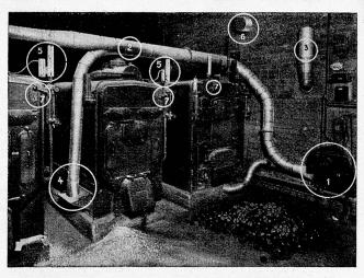
1 Ventilator 2 Luftrohrleitung 3 Ansaugleltung (erwärmte Luft Lufteintritt zum Aschenraum des Kessels und autom. Regulierung der Verbrennungsluft
