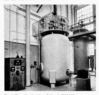
Fig. 4 Chaudière èlectrique Sulzer de 5000 kW et son panneau de réglage; au fond un transformateur de chaleur. Sulzer Elektrokessel von 5000 kW mit Schalttafel; im Hintergrund ein Wärmeumformer.
