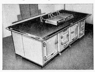
ESSE-Major-Herdanlage, mit rückseitig eingebautem Wärmeschrank und Heisswasserbereitung (rechts aussen)
