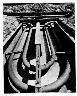
Fig. 10 Boucle de dilatation dans les canalisations d'eau surchauffée.
