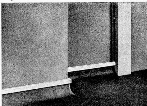
Abbildung 1 Modell A, ausspringende Ecke, scharf und Türanschluss
