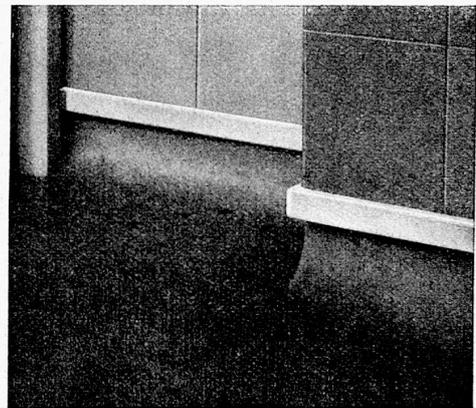
Abbildung 2 Modell B, 'ein- und ausspringende Ecken (scharf) und Türanschluss
