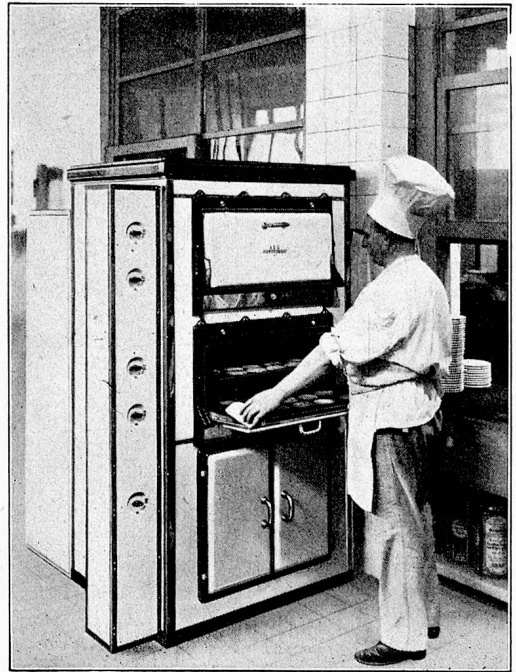
Elektrokonditorei - Backofen mit 2 Backröhren und einem Gärschrank
