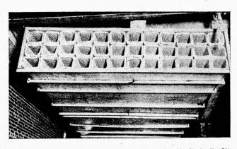
Abbildung 10 Photo ausgeführter Schalldämpfer für die Radio City in New-York. (Aus Heating and Ventaling, New-York)
