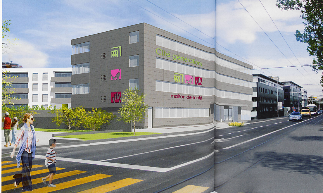
Le projet Cité Générations tel qu'il apparaîtra le long de la route de Chancy, au coeur de la ville d'Onex. Au premier plan, la Maison de Santé, à l'arrière la Cité Générations avec son habitat intergénérationnel.
