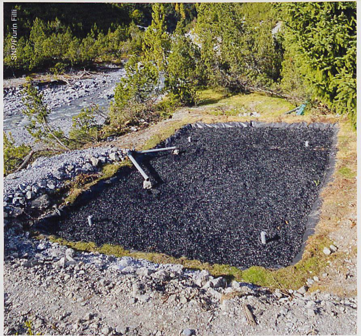
Die neue biologische Kläranlage verfügt neben Wurmkompost über ein zusätzliches Pflanzenbecken, das 2022 bepflanzt wird und für die abschliessende Klärung sorgt.
