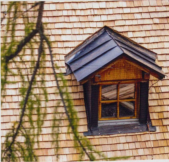
Wie zu alten Zeiten ist das Dach der Haupthütte wieder mit handgespaltenen Lärchenschindeln gedeckt.
