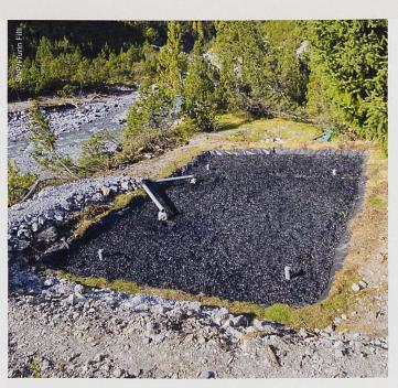
Die neue biologische Kläranlage verfügt nebst Wurmkompost über ein zusätzliches Pflanzenbecken, das 2022 bepflanzt wird und für die abschliessende Klärung sorgt.
