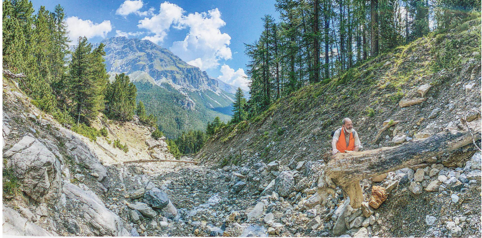
Die Val Brüna erstreckt sich auf der linken Seite des Fuorn-Tals bei Stabelchod in Richtung Munt Chavagl. Hier rauschen bei Starkniederschlägen regelmässig Murgänge ins Tal.
