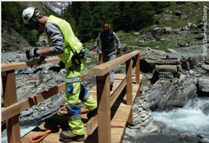
Brückenbau in der Val Trupchun
