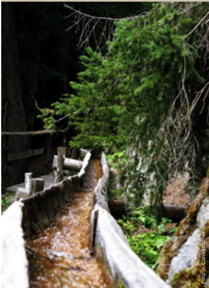
Früher wurden die Rundholzkanäle oft aus Arvenholz hergestellt.
