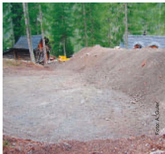
Neu errichteter Damd zur Ablenkung von Murgängen oberhalb des Blockhauses Cluozza
