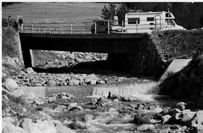
Foto 3: Schwelle der Brückensicherung beim Hotel Il Fuorn.
