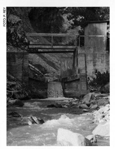
Foto 2: Schwelle der hydrologischen Messstation bei Punt la Drossa.
