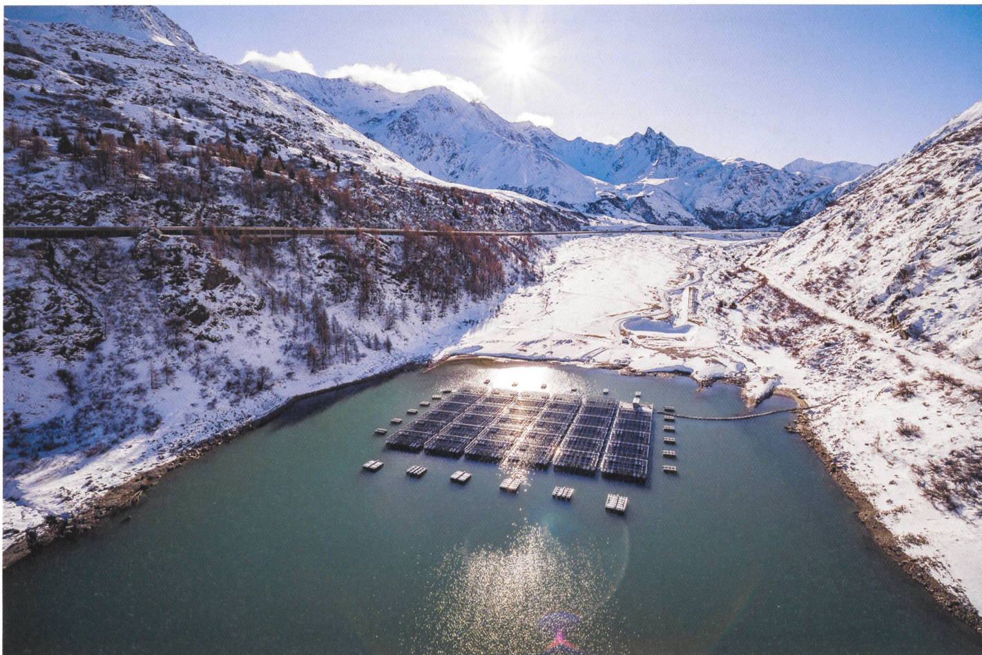
[ILL. 1] Parc solaire flottant du lac des Toules en hiver / Der schwimmende Solarpark auf dem Lac des Toules im Winter / Il parco solare galleggiante del Lac des Toules d'inverno (Source : Romande Énergie, photo : Valentin Flauraud)
