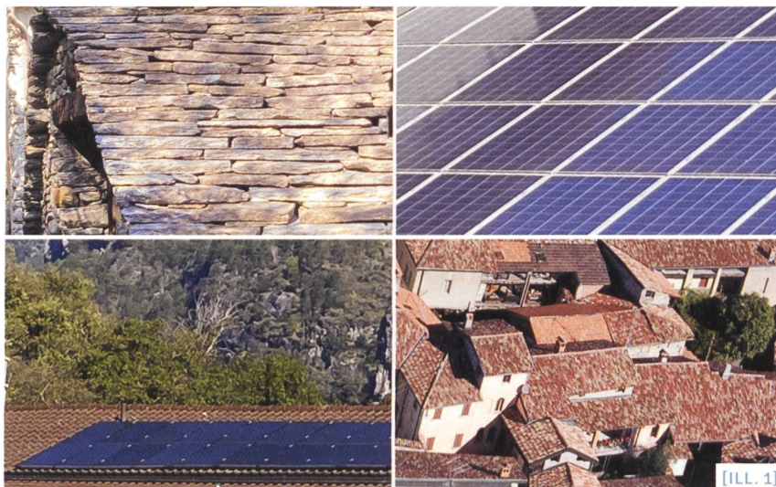
[ILL. 1] Impatto degli impianti solari: contrasto tra superfici liscemoderne e materiali storici / Auswirkungen von Solaranlagen: der Kontrast zwischen modernen, glatten Oberflächen und historischen Materialien / Impact des installations solaires: contraste entre surfaces lisses modernes et matériaux historiques (Fonte: Planidea SA)
