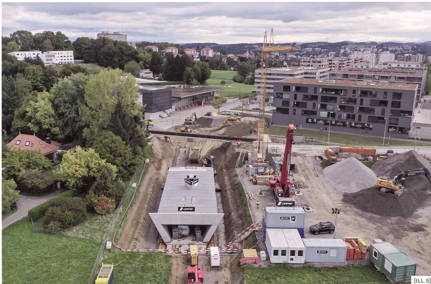
[ILL.5] Passage inférieur en construction sous la route cantonale à Villars-sur-Glâne, ouvrage de 1500 tonnes / Bau der Unterführung an der Kantonsstrasse in Villars-sur-Glâne, ein 1500 Tonnen schweres Bauwerk / Sottopasso in costruzione sotto la strada cantonale a Villars-sur-Glâne, un'opera di 1500 tonnellate (Photo: Sylvain Zehnder)
