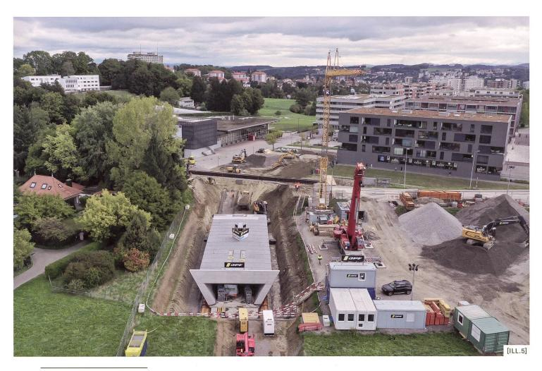
[ILL.5] Passage inférieur en construction sous la route cantonale à Villars-sur-Glâne, ouvrage de 1500 tonnes/
