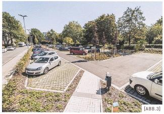
[ABB.2] Beispiel einer Überflutungsmulde für die kurzfristige Aufnahme grosser Regenmengen in Dinslaken /
