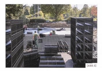
[ABB.5] Einbau von unterirdischen Rigolen unter einem Parkplatz in Herne / Installation de rigoles souterraines sous un parking à Herne / Costruzione di canaletti drenanti sotterranei per un parcheggio a Herne (Quelle: Rupert Oberhäuser, EGLV)
