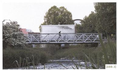
[ABB.3] Auf der Fuss- und Velobrücke rauscht das Wasser in Augenhöhe. Die schlanke Konstruktion des 15 m² grossen Wasserschleiers teilt die Brücke der Länge nach in zwei Hälften. (Foto: Metallatelier)
