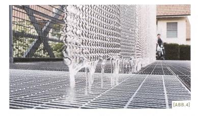
[ABB.4] Der rechteckige Rahmen aus Metall spannt auf sechs Metern Länge ein knapp drei Meter hohes Edelstahlnetz, ein so genanntes Ringgeflecht, das von oben mit dem aus der Reppisch stammenden Wasser berieselt wird. (Foto: Metallatelier)
