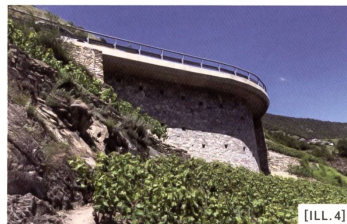
[ILL.4] Murs de soutènement intégrés au vignoble entre Granges et Lens / In Rebberge integrierte Stützmauern, Kantonsstrasse Granges-Lens / Pareti di sostegno integrate in un vigneto, strada cantonale Granges-Lens (Source: Etat du Valais)
