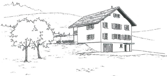
[ABB. 2] Landschaftlich wenig sensibel sind Lösungen mit unschönen Stützmauern, meist mit Absturzsicherung. Viel besser eingepasst sind nicht zu steile Böschungen.
